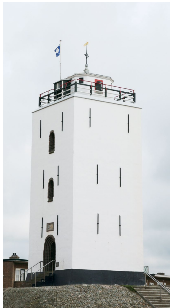
De vuurbaak van Katwijk is gebouwd omstreeks 1605 en is, na de Brandaris op Terschelling, het oudste vuurtorengbouw van Nederland. De toren heeft nog het karakter van een vuurboet. Hij wordt in Katwijk ook Vierboet genoemd. Tot halverwege de 19 e eeuw werd op het platte dak een vuur gestookt. Daarna ging met over op een olielamp met reflector. Sinds 1912, toen in Katwijk geen bomschuiten meer op het strand landden, is de vuurbaak buiten gebruik. Foto: Bert Knottenbeld, Flickr.com
