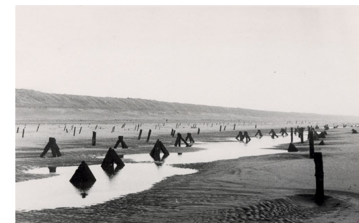
In het duingebied liggen nog steeds veel resten van de Atlantikwall, die op het strand zijn allemaal opgeruimd. Op de foto versperringspalen en 'Rommelasperges', veelal voorzien van mijnen, op het Wassenaarse strand, waarschijnlijk 1945. Gemeentearchief Wassenaar nr. 08518.
