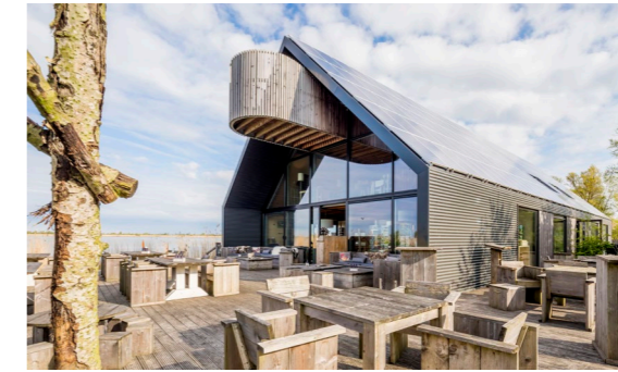
Dak Buitencentrum Oostvaardersplassen voorzien van zonnepanelen
