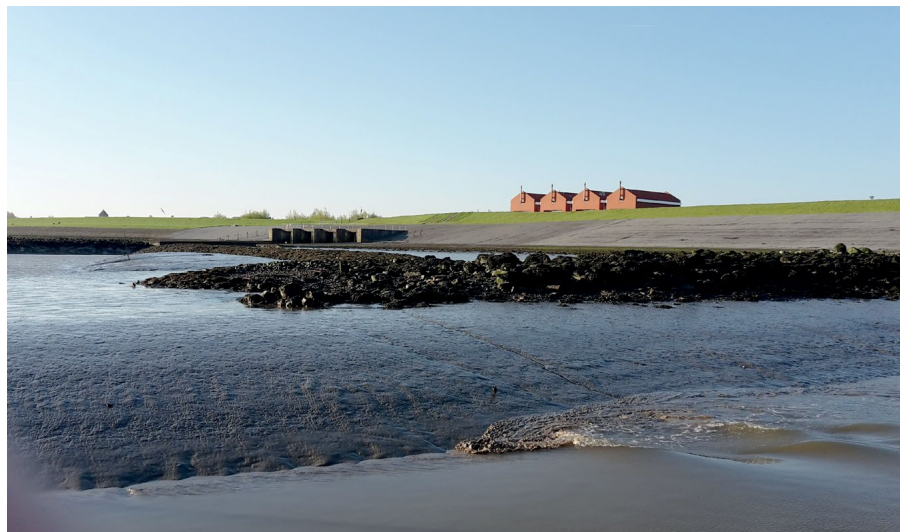
Basaltdammen geleiden zowel de stroming voor de havenmonding (Munterzijl) op de voorgrond als de uitmonding van het gemaal Rozema op de achtergrond bij Termunterzijl. De geul wordt begrensd door de drooggevallen slikken op de overgang van de Eems naar de Mond van de Dollard.
