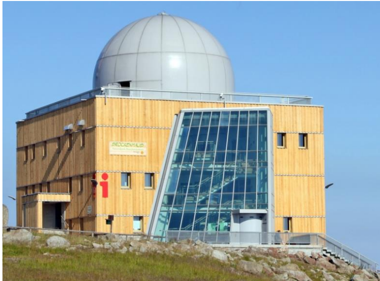
Figuur 27. Das Nationalpark-Besucherzentrum Brockenhaus auf dem Brockengipfel (Brockenhaus, 2019 foto door Christoph Lampert)
