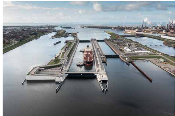
Het sluizencomplex bij IJmuiden
